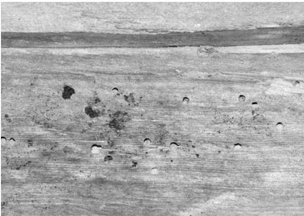
Aikuisten kovakuoriaisten ulostuloreiät / lentoreiät puun pinnalla ovat halkaisijaltaan noin 2 mm. Hirsijumin parveilu aika voi vaihdella ilmasto-olosuhteiden mukaan toukokuun alkupuolelta elokuun loppuun.
