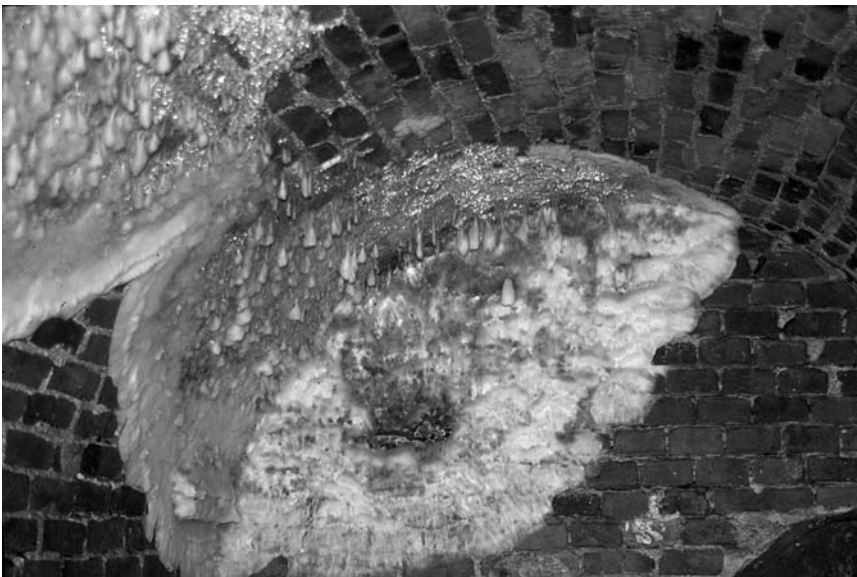
Yläpuolisessa salissa lattia notkui vieraiden tanssiessa, mutta alapuolen viinikellarissa aika oli pysähtynyt: viinipullorivistöjen sijasta kellarin hallitsi itkevä rihmasto.
