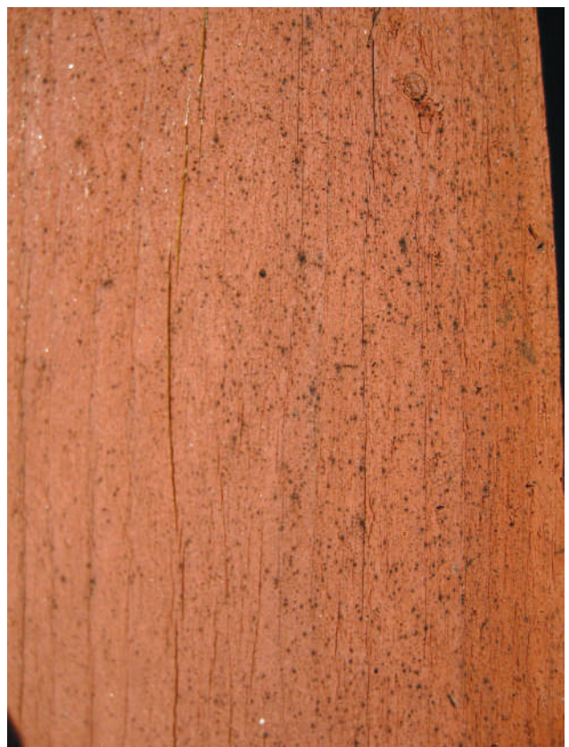
Kuusi vuotta sitten punamullattua, homeen pilkuttamaa pintaa. Tätä seinää ei käsitelty boorilla.
