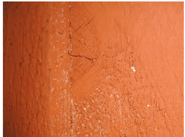
Muutamissa kohdin, joissa puu on imenyt erityisen paljon booriliuosta, on vieläkin nähtävissä kiteytymiä.
