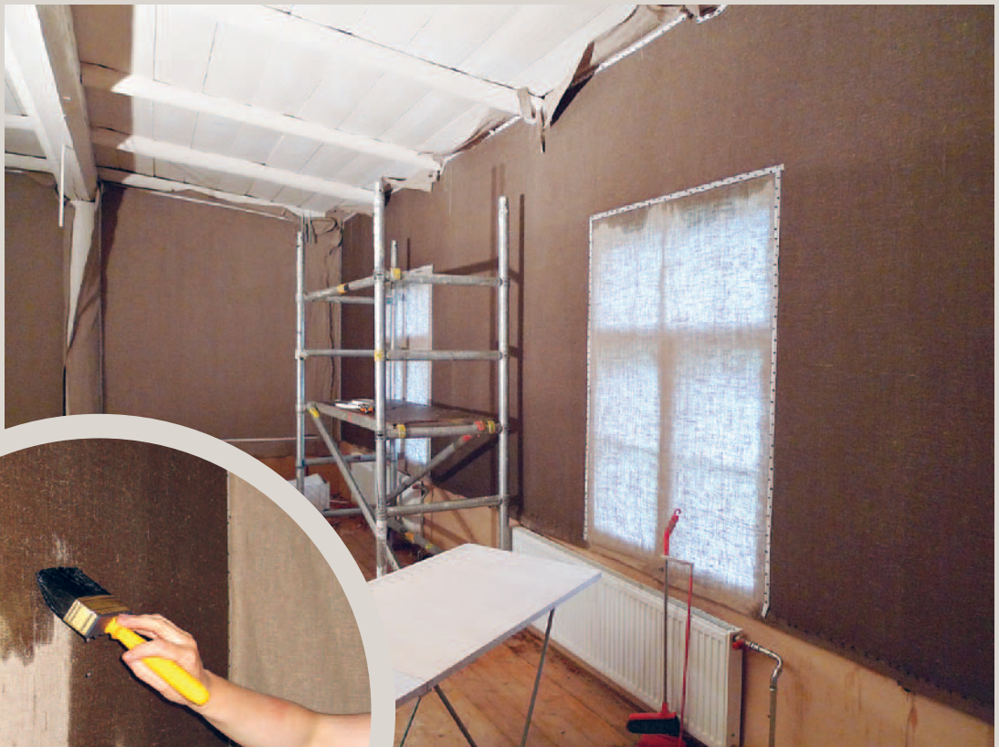
Näkymä pingotuskohteesta. Salin pitemmät seinät olivat lähes kahdeksanmetriset. Alaosaan tuli lopuksi panelointi. Haastetta työhön toi katon palkisto.
