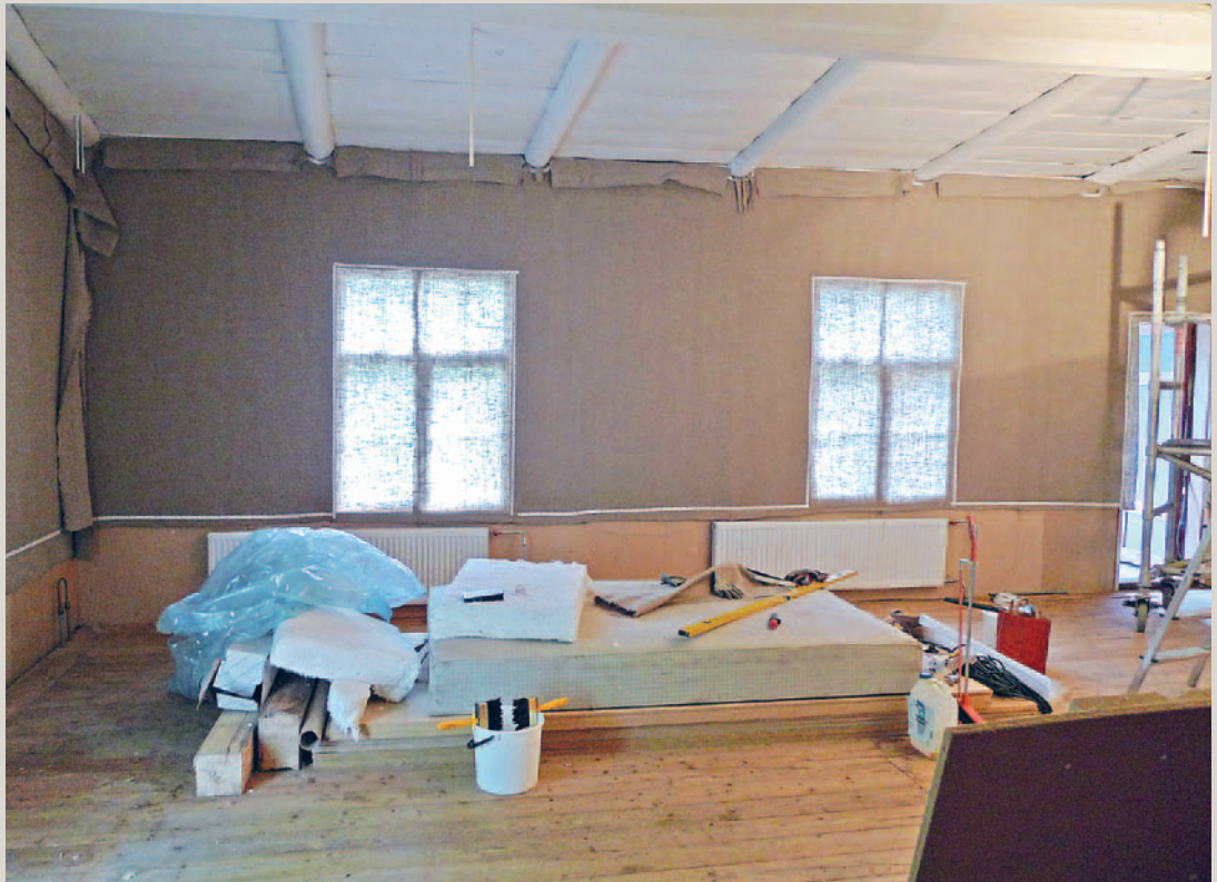
Näkymä pingotuskohteesta. Salin pitemmät seinät olivat lähes kahdeksanmetriset. Alaosaan tuli lopuksi panelointi. Haastetta työhön toi katon palkisto.
